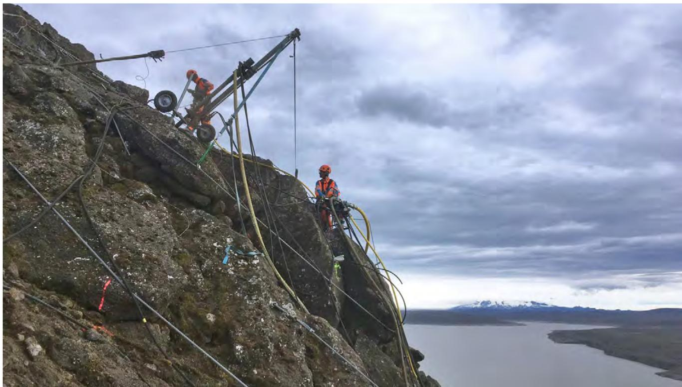
Das Problem der Installation von Schutzvorrichtungen wurde der **Lumesa SA** vorgelegt. Früher wurden diese Strukturen mit Raupenmaschinen ausgeführt. Da diese nicht immer ausreichend waren, wurde eine tragbare Maschine entworfen.
