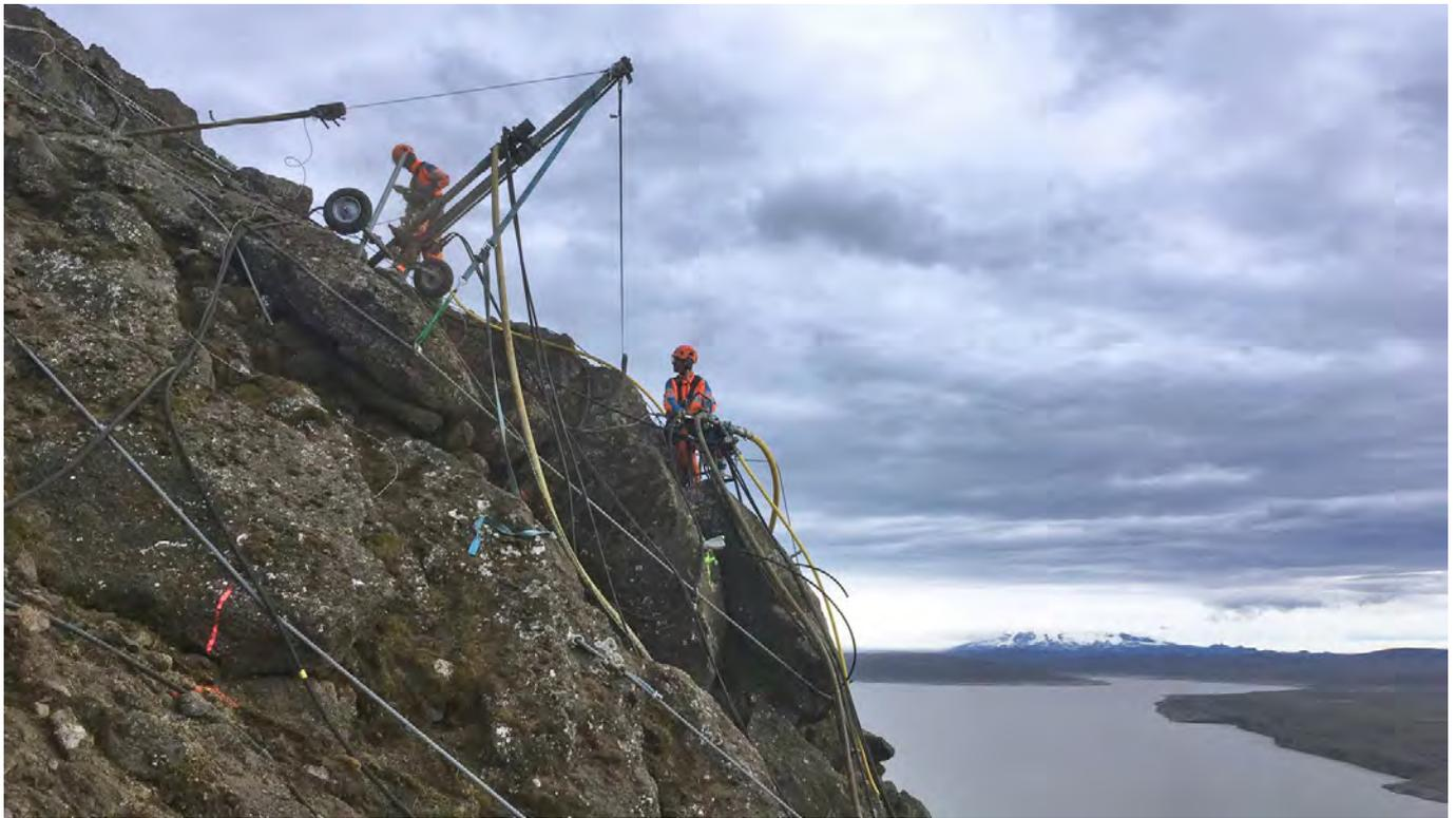
Das Problem der Installation von Schutzvorrichtungen wurde der **Lumesa SA** vorgelegt. Früher wurden diese Strukturen mit Raupenmaschinen ausgeführt. Da diese nicht immer ausreichend waren, wurde eine tragbare Maschine entworfen.
