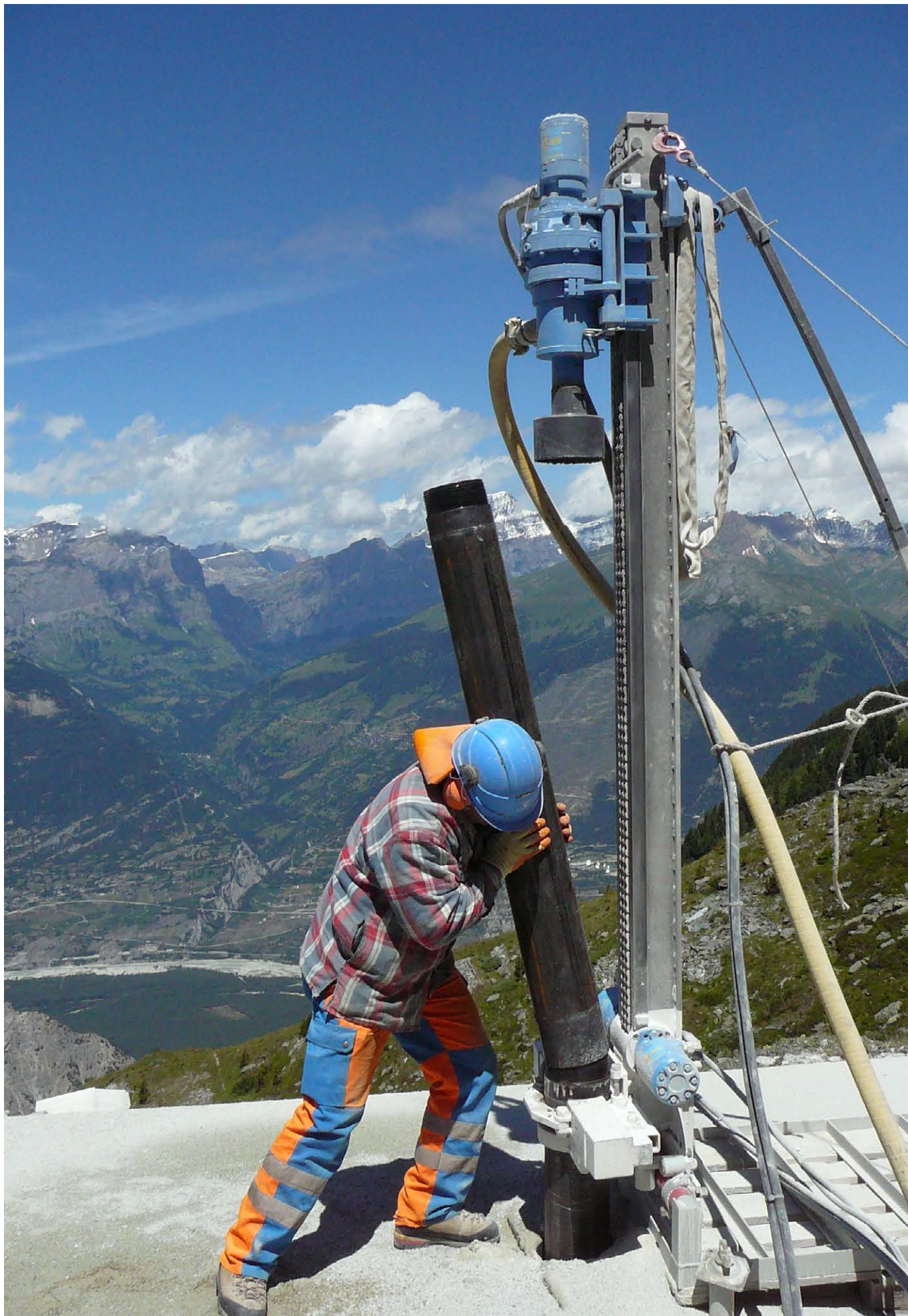
Mounty® H 92 S, Durchmesser 216 mm; Länge 40 Meter, Probebohrung Staumauer Illsee, Leuk VS, Schweiz
